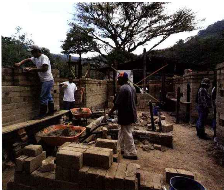
Au Nicaragua, le voyageur équitable Ecotour soutient l'édification d'un éco-gîte. Ce dernier va permettre de former 15 représentants des communautés locales rurales aux techniques d'autoconstruction en terre comprimée.
